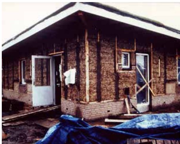
Klaar voor de afwerking met leemstuc
