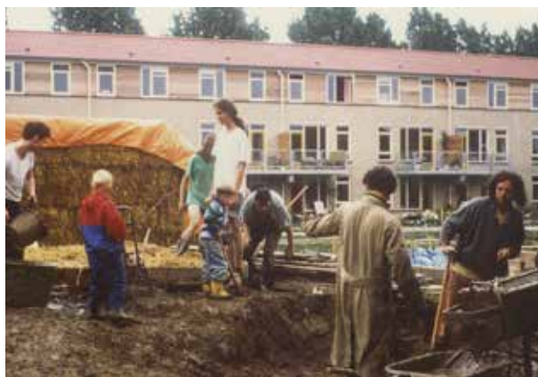
Het produceren van het stroleem
