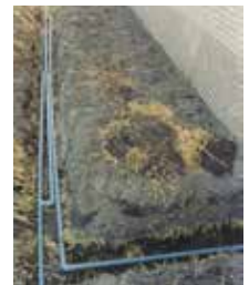
Helofytenfilter in aanleg
